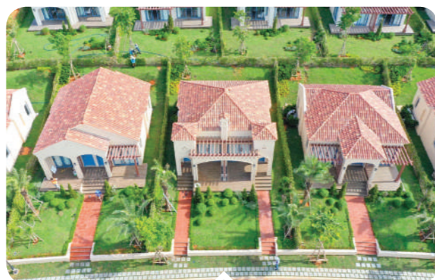
Công trình xây dựng 9 Lô Biệt thự tại Bình Châu - Vũng Tàu
