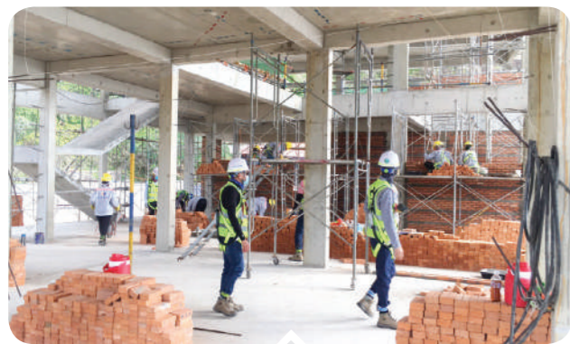
Công trình xây dựng khu điều hành Công ty Bất động sản Quảng Bình - TP Đồng Hới Tổng đầu tư: 116 tỷ - Đang thi công
